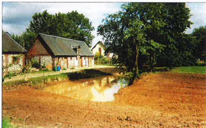
Au-delà d'une certaine surface, le recours à une pelle mécanique est inévitable. Ici : réhabilitation en mare d'un ancien « trou à fumier ».
