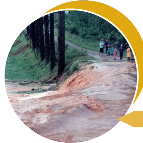
Inondations à Cideville en 1993
