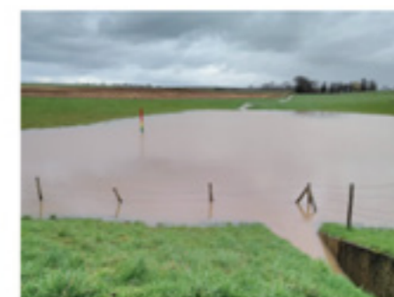
Au même endroit, suite à de fortes pluies en janvier 2018, l'ouvrage se remplit en stockant les eaux de ruissellement.
